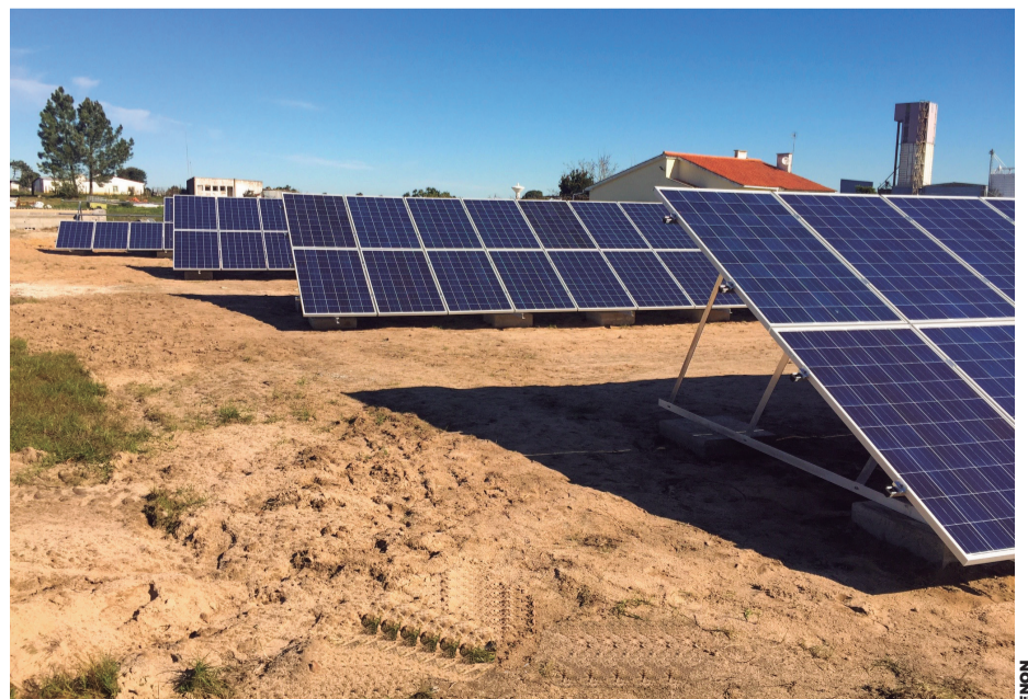
Instalação Fotovoltaica de 66 kWp na empresa Decapagem e Metalização Triunfo, Lda. 264 módulos policristalinos de 250W
