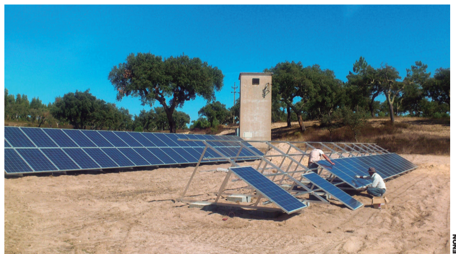
Instalação Fotovoltaica de 20 kWp na Sociedade Agrícola Diconsa, Lda. 80 módulos policristalinos de 250W
