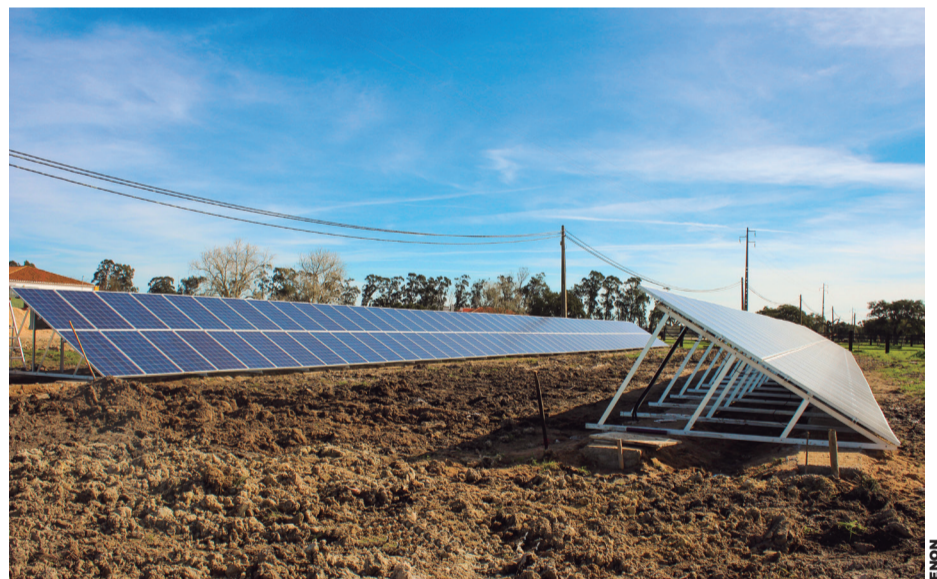
Instalação Fotovoltaica de 49.5 kWp na Herdade da Adema. 198 módulos policristalinos de 250W
